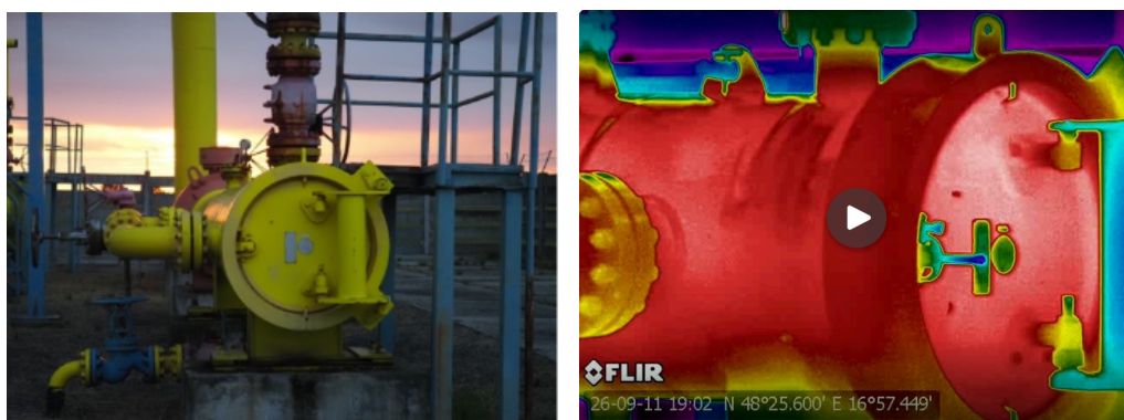
Fig. 3: Pig trap - Čistiaci uzol plynovodov Jakubov [video link]
