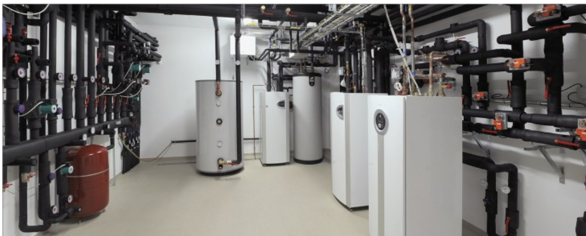
Tepelný rozvod s tepelnými čerpadlami s akumuláčnými zásobníkmi vody
